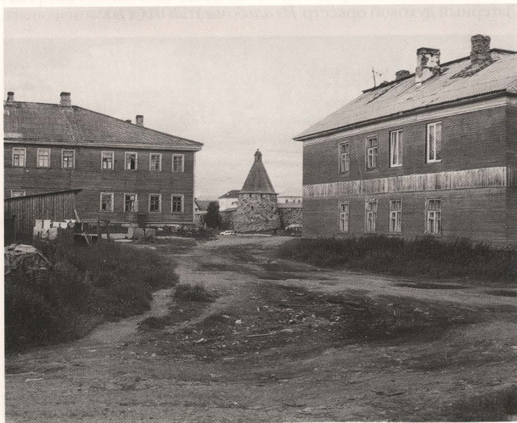
Рабпоселок на Большом Соловецком острове. Современный вид
